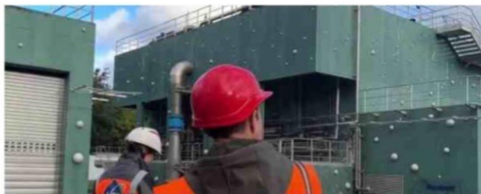
L'une de stations d'épuration du Siba à Biganos. PH CAPTURE D'ÉCRAN TVBA
